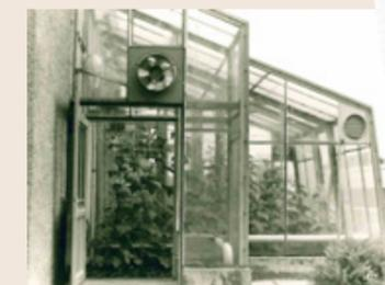
Gewächshauskabine zur Messung der Photosynthese an Pflanzenbeständen aus dem Jahr 1973.
